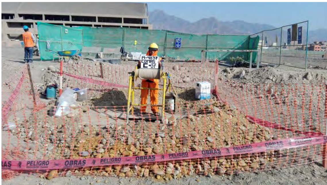
CALICATA C-37. SE APRECIA EL EQUIPO UTILIZADO PARA EXTRAER LOS MATERIALES DE LA EXCAVACIÓN.
